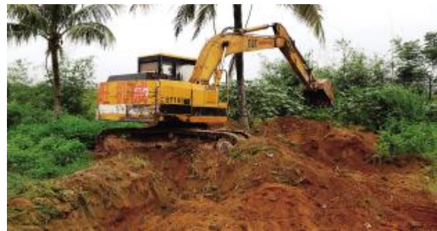
挖掘机正在平整地面。黄祥 摄
