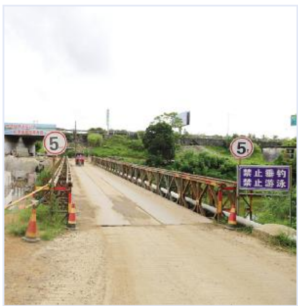
9月13日,记者在居丁互通匝道连接线养护工程现场看到,施工人员正在马不停蹄地工作,下村桥重建工程已经接近尾声。据相关负责人介绍,9月底下村桥重建工程将完成架梁阶段,10月下旬可以实现半幅通车,届时,所有过往车辆将无需绕行。(黄祥)
