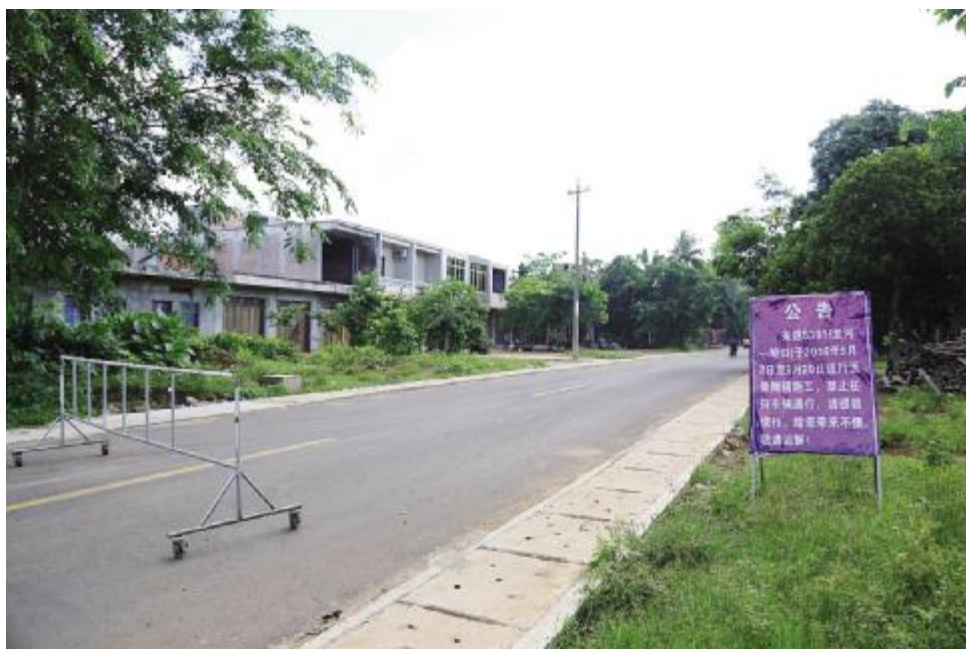
近日,记者在岭口距离翰林1公里处看到,道路上围起了护栏,车辆暂时不能通行。据了解,省道S301(龙河-岭口)于2016年9月2日至9月20日进行沥青摊铺施工,禁止任何车辆通行,请过往车辆提前做好绕行准备。(黄祥)
