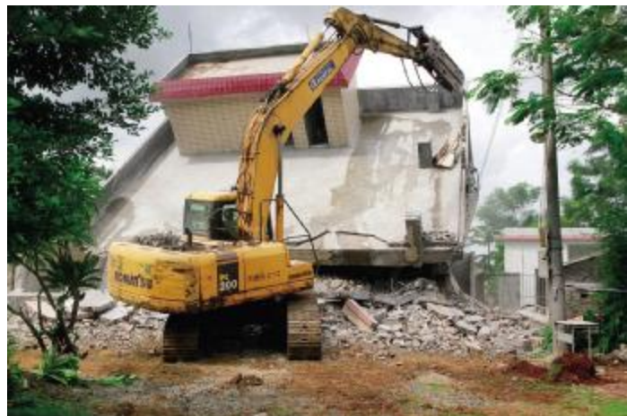
违规建筑拆除现场。薛陶陶 摄
