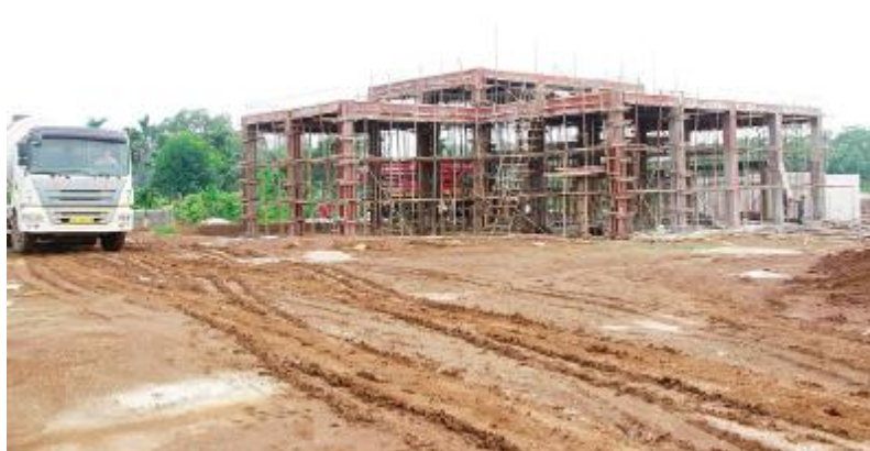
黄竹供水工程项目中的净水厂部分正在建设中。薛陶陶 摄
