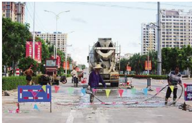
工人正在修复兴安大道破损路面。王聘钊 摄
