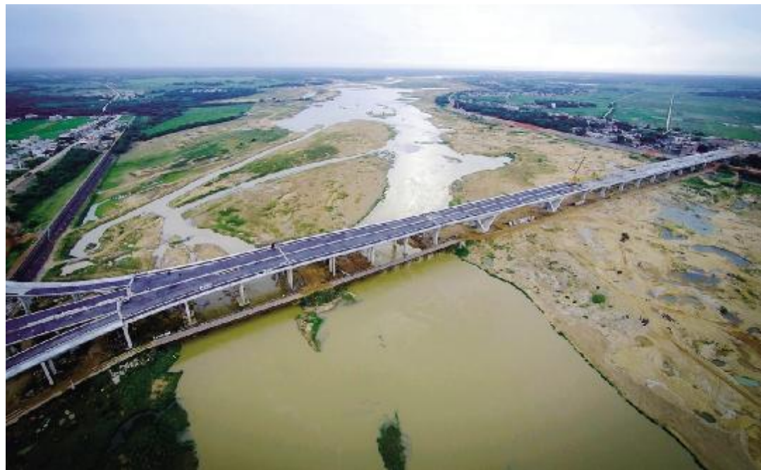
航拍定海大桥。海南日报记者 袁琛 摄
