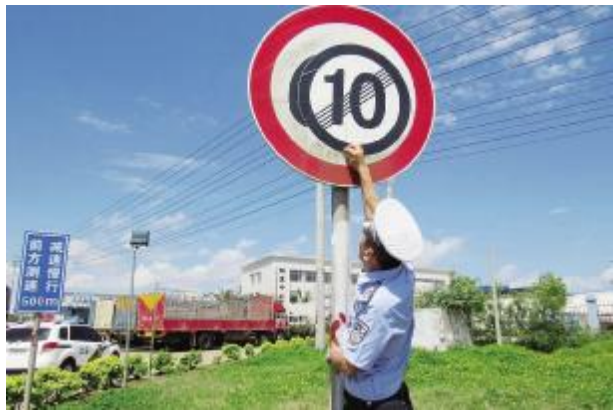
交管大队对部分交通标志标线不全的路口路段进行增补施划。
