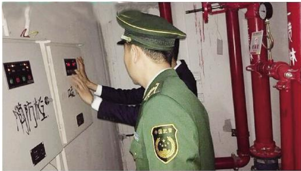
检查消防设施。李琼英 摄
