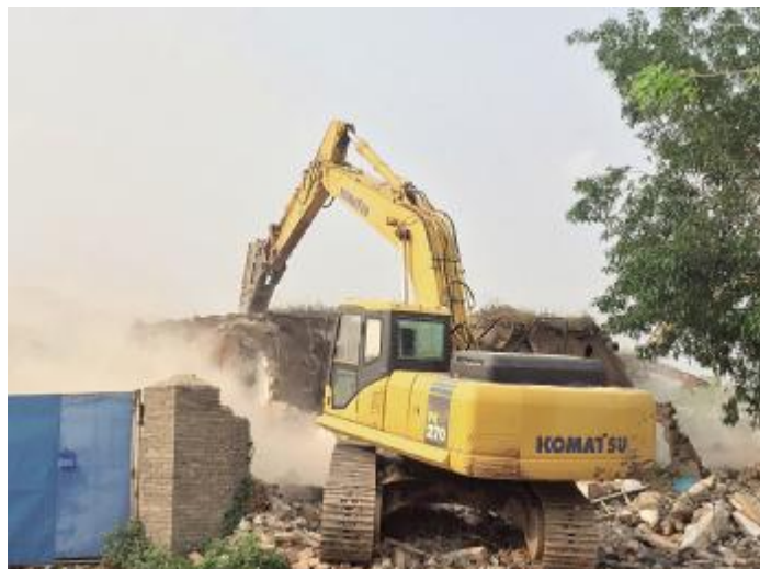
挖掘机拆除违建建筑。黄祥 摄
