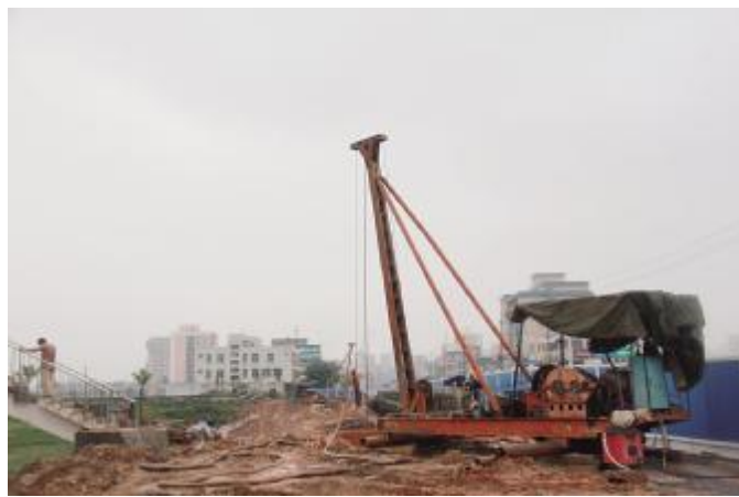
潭榄桥改建工程现场。叶松 摄
