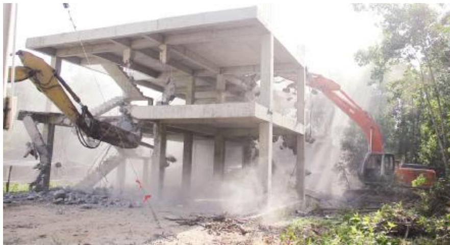
拆违现场。叶松 摄
