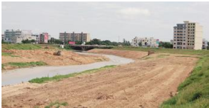
潭榄溪河道疏浚工程建设现场。叶松 摄
