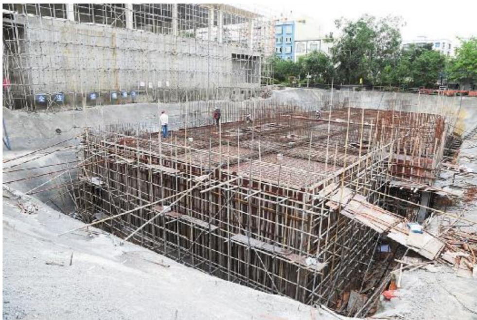
“固定好钢筋,明天就开始浇筑回收水池了。”4月28日,记者在定城供水扩建工程施工现场看到,该项目自2014年1月开工以来,工程稳步推进,目前蓄水池、泵房、清水池等主要建筑已经完工,各项施工项目在井然有序的进行着。
