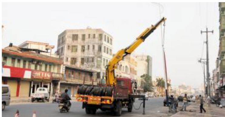
见龙大道施工单位人员正在安装新型节能路灯。黄荣海 摄
