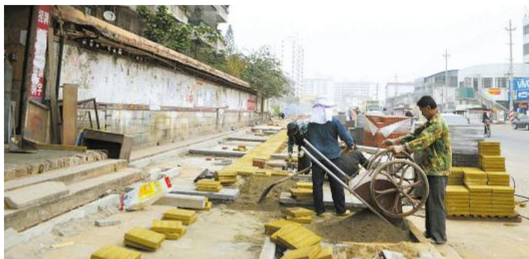
施工人员对人行道进行改造。黄荣海 摄
