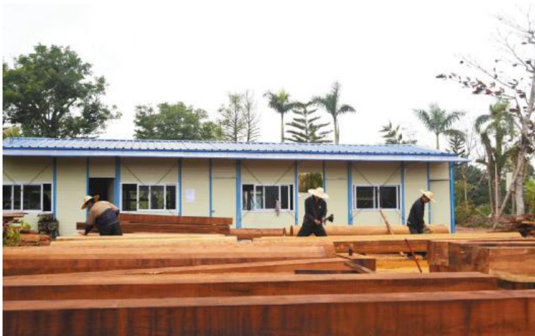
修复老县衙木工建设已开工。何慧 摄
