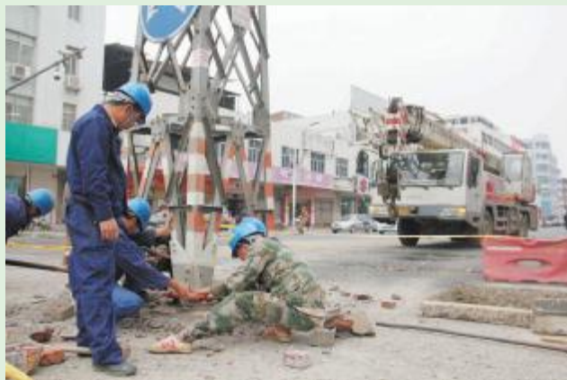
12月23日,工作人员对定城镇一杆“占道”多年的十千伏线路铁塔进行拆除。 叶松 摄
