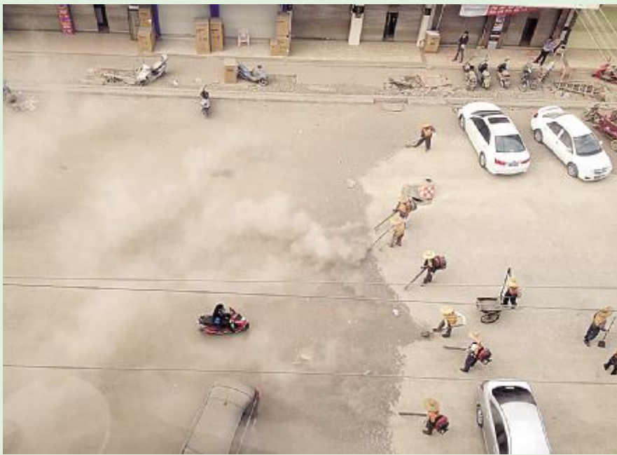
环卫工人正在进行铺沥青前的清理。12月14日15点32分，见龙大道人民中路汽车站路段。王娇 摄
