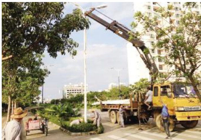
现场工作人员拆卸损坏的路灯。王伦 摄
