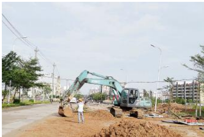
台风过后,见龙大道施工工人立即调度挖掘机进行抢修、清淤、疏通。
