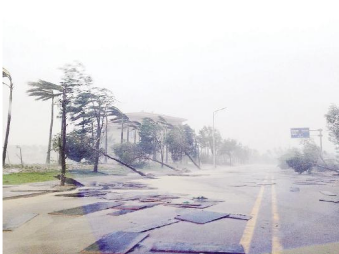
弘海路与环城南路交汇处,建筑模板被台风刮起散落一地,给交通带来不便。王聘钊 摄
