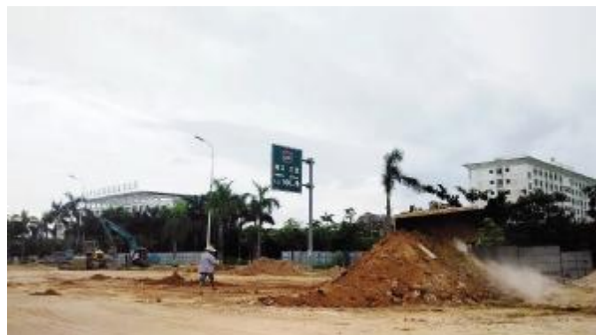
7月17日,“威马逊”登陆前夕,定安县人才劳动力市场大楼前,一台推土机和两台挖掘机正奋力将路面的堆土碾平,同时填平路边的鸿沟。林凤玉 摄
