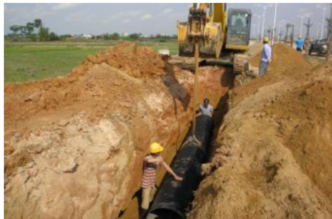
填埋水管施工现场。王启汉 摄
