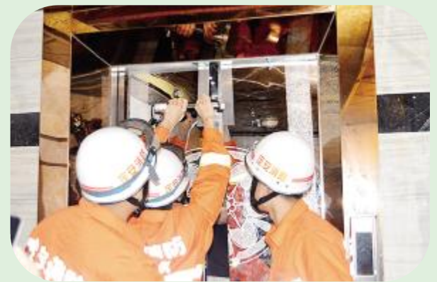
2014年5月23日02时12分,定城镇和平南路麦乐迪KTV电梯发生故障,导致8名人员被困,定安县消防中队接到报警后,迅速展开救援。蒋卷勇 摄
