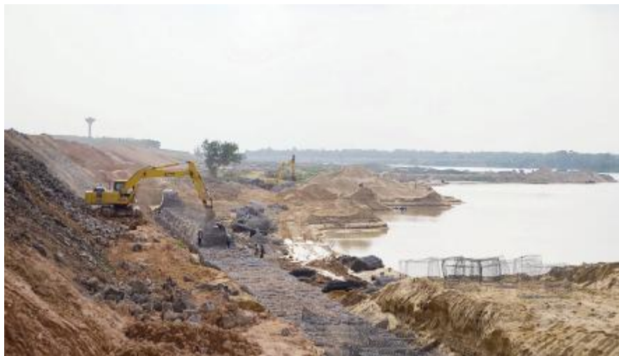
南渡江防洪大堤二期工程正在紧张施工。 黄荣海 摄
