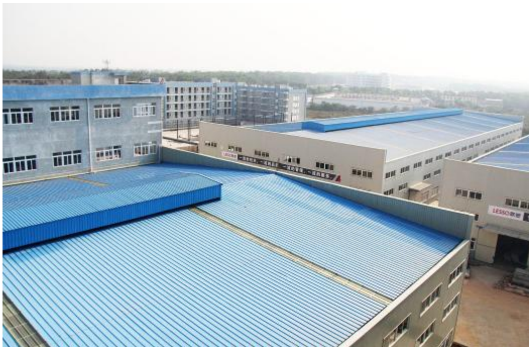
联盟管道海南生产基地项目的生产车间已完工,近期将实。叶松 摄
