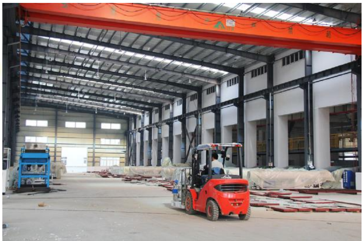
人正在安装设备。 在中国联塑塑料管道海南生产基地，工 叶松 摄
