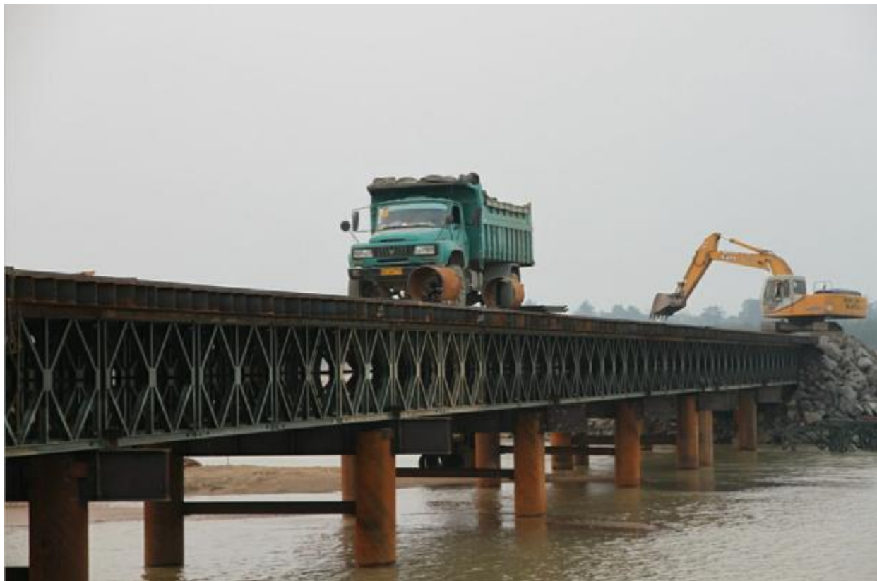
定海大桥过江栈道正在紧张施工中。叶彦彤 摄
