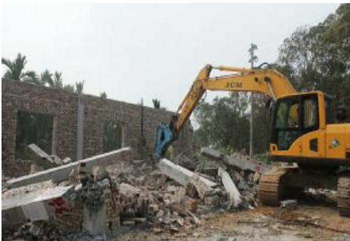
定安依法强拆违法建筑现场。林先锋 摄
