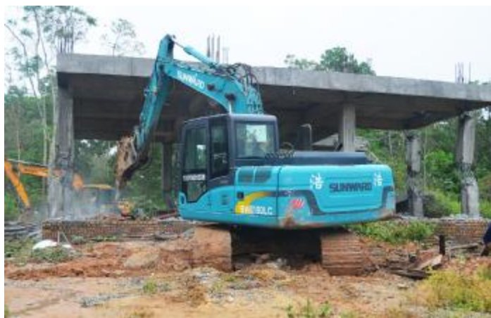
10月17日上午,2辆大型机械同时作业,对定安县定城镇北侧的违法建筑进行拆除。 陈慧 摄
