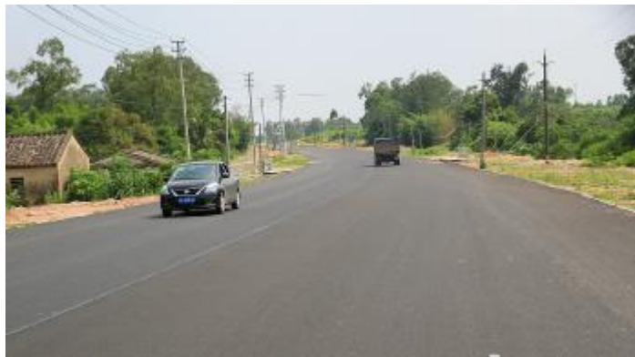
崭新的沥青混凝土路面。梁绮艳 摄
