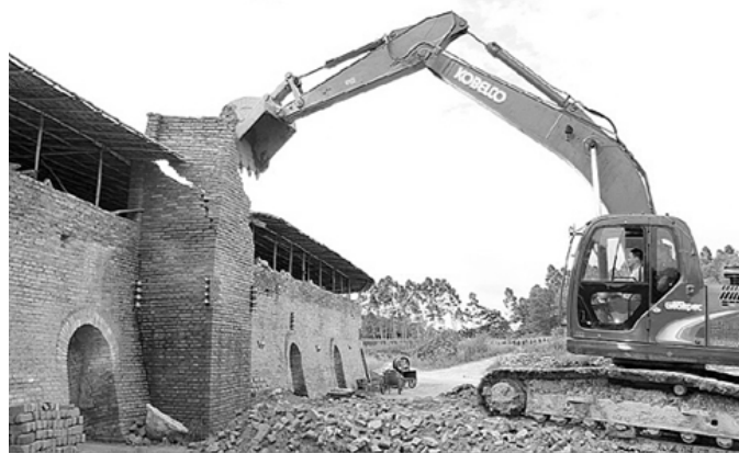
定安县拆除最后一家实心粘土砖厂。吴采净 摄
