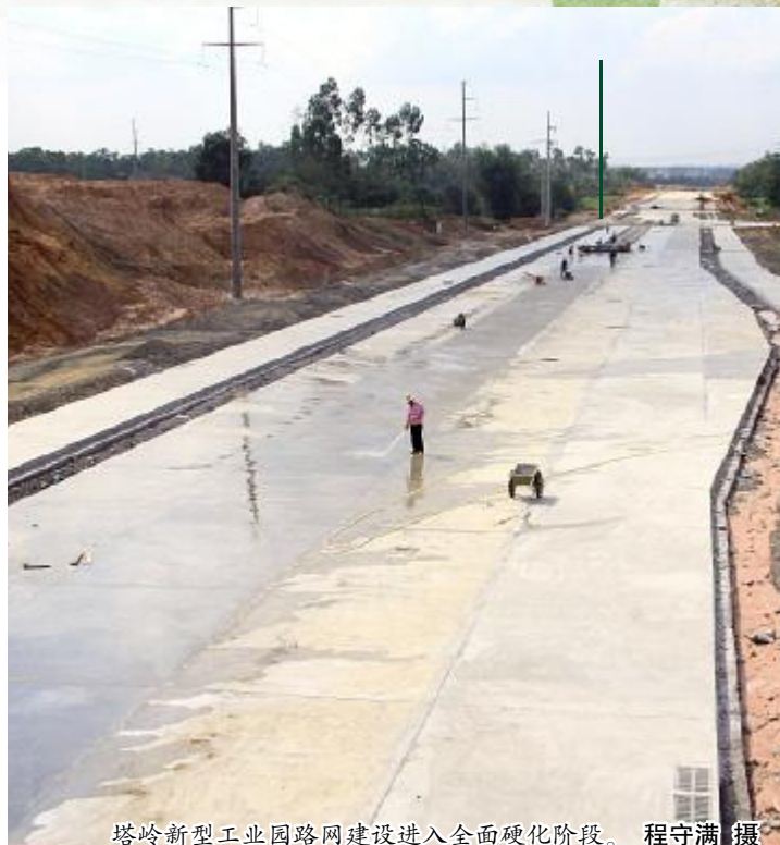
塔岭新型工业园路网建设进入全面硬化阶段。程守满 摄
