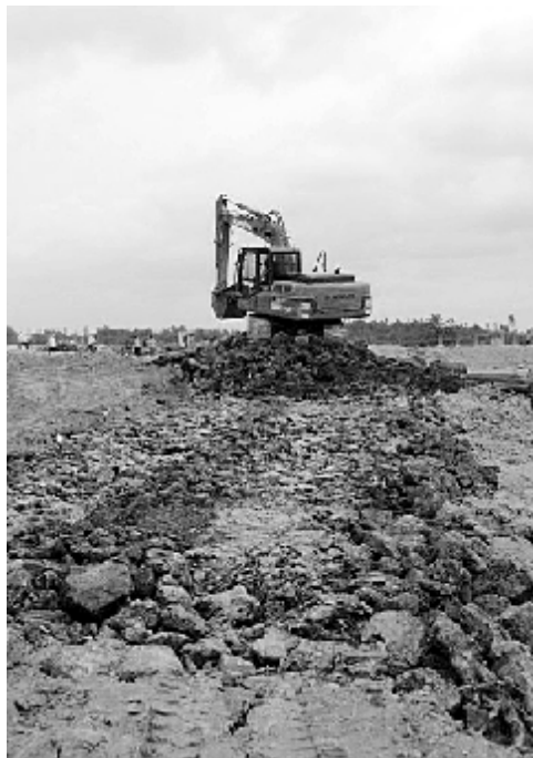
挖土机在进行第二层便道路铺设。王议霄 摄
