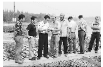
水利工程建设质量安全至关重要。罗利明摄
