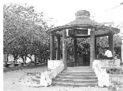
亭在定城东门,今县工人文化宫院墙内。亭建于民国18年,为圆形钢筋混凝土构筑物。有亭座,对开二门,左右侧有水泥座位,座基台阶四级。亭直径5米,有八根圆柱,柱高242米。亭地面至顶350米,亭顶为覆钵形,上饰圆球顶,全高48米。
