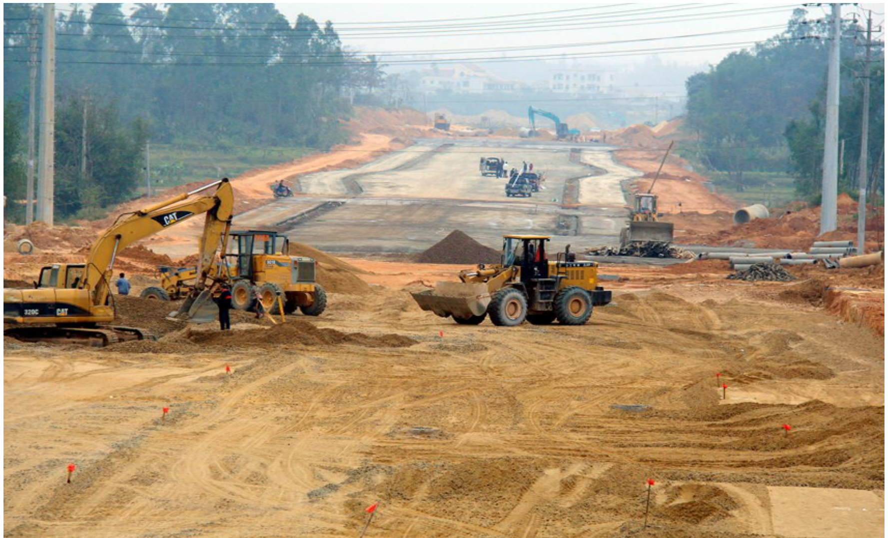
塔岭工业园区基础设施建设正在热火朝天推进中。王聘钊 摄
