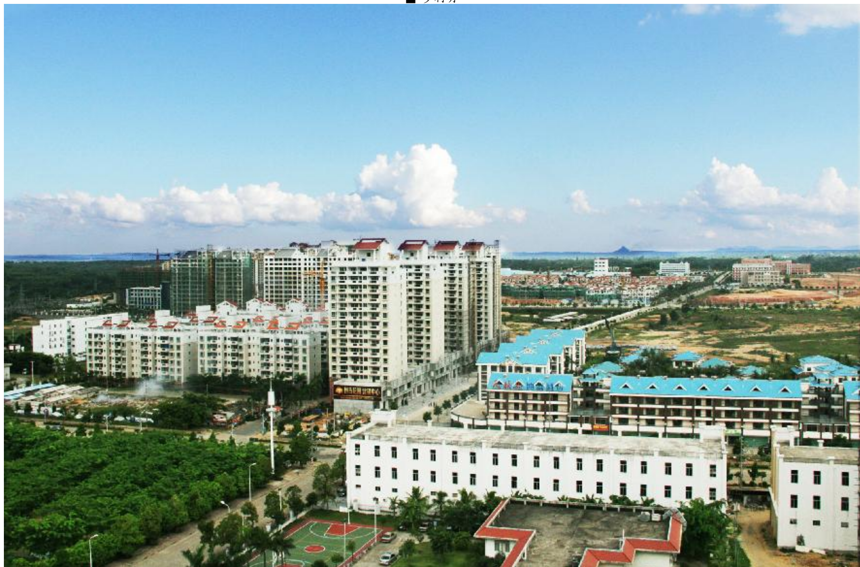
建设中的塔岭工业园区。 梁源富 摄
