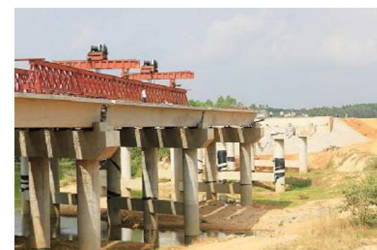
塔岭工业园新区路网建设日趋完善。林先锋 摄
