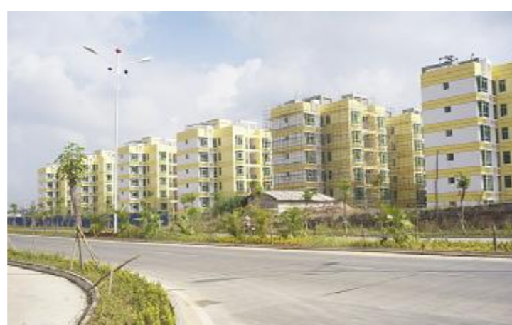
保障性住房托起安居梦。莫云峰 摄
