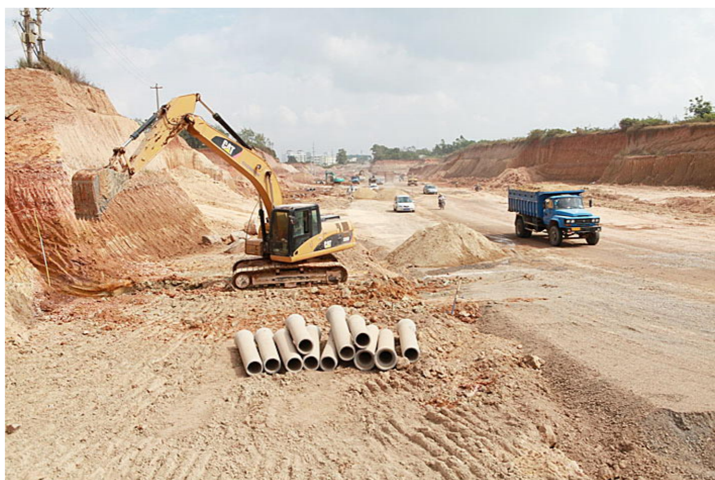
官墩脊工地上，项目建设如火如荼。卓昌斌 摄
