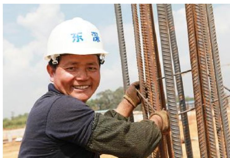
工人正在加紧建设项目。卓昌斌 摄
