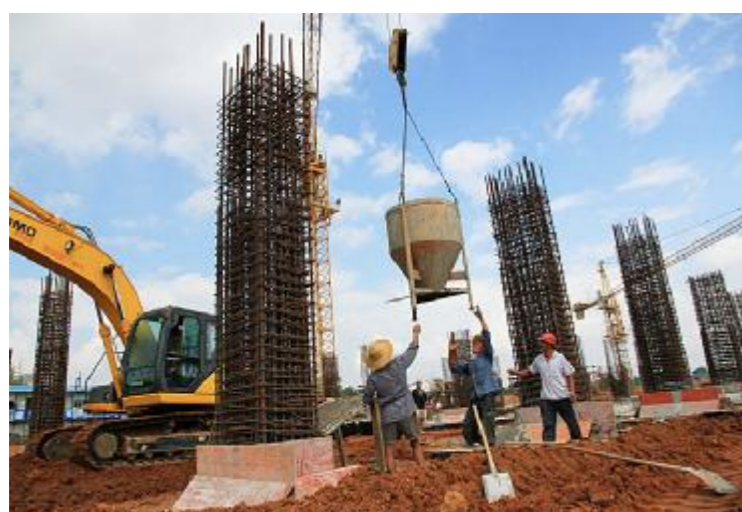
项目工地建设一派热火朝天的景象。林先锋 摄
