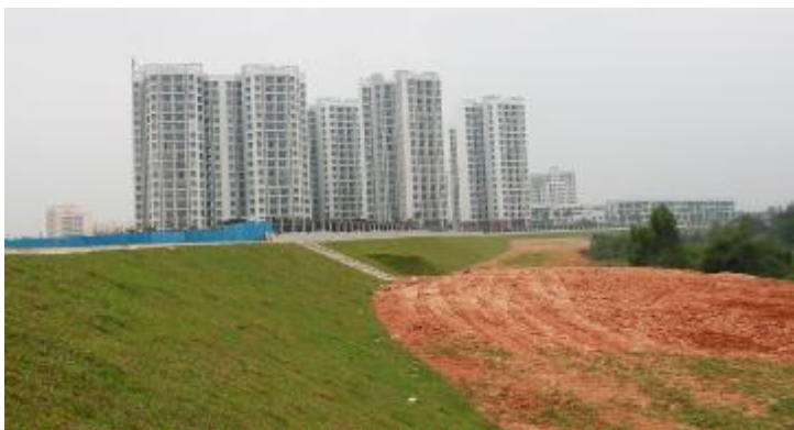
正在建设的潭榄溪综合整治工程一角。梁绮艳 摄
