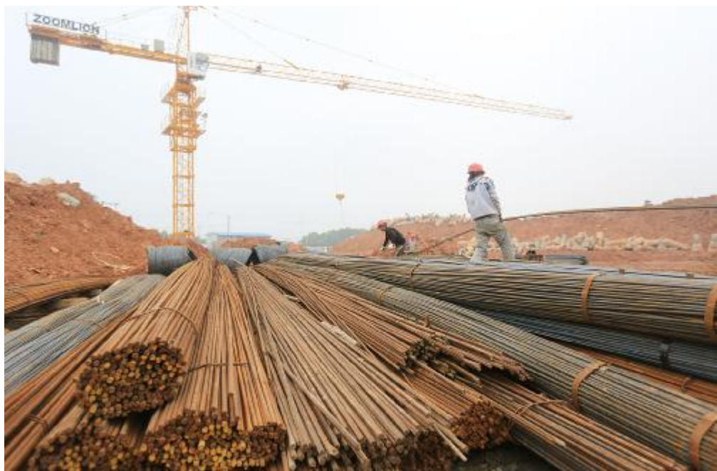
定安县保障房建设强力推进。罗利明 摄
