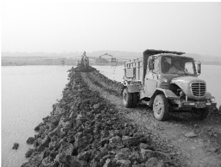
正在紧张施工中的拦河坝修筑现场。县自来水公司提供
