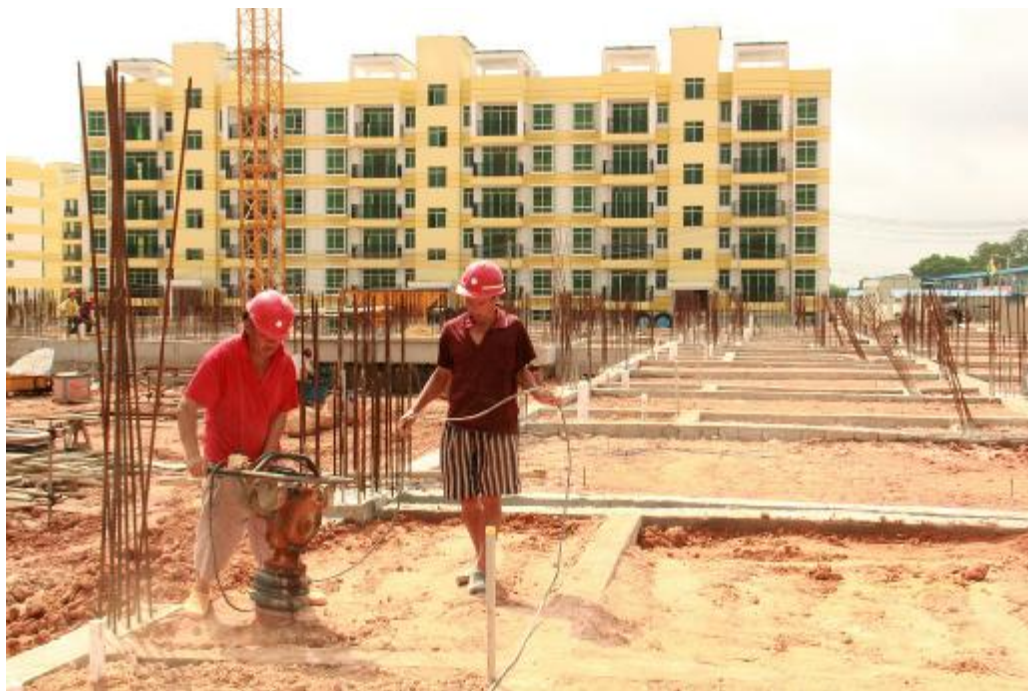
工人加班加点推进保障性住房建设。李召君 摄
