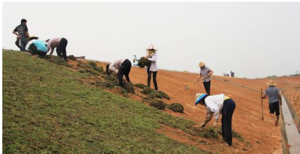
工人们正在紧张有序地对防洪堤两侧草皮进行铺设。罗利明 摄
